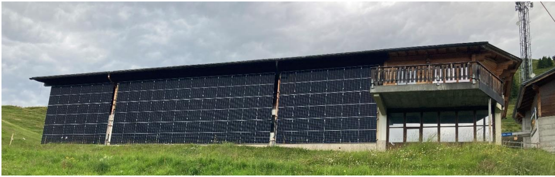
Abb. 162 Beispiel Käserstatt: im 2023 installierte Solarpanels an der Fassade des alten Bergrestaurants
