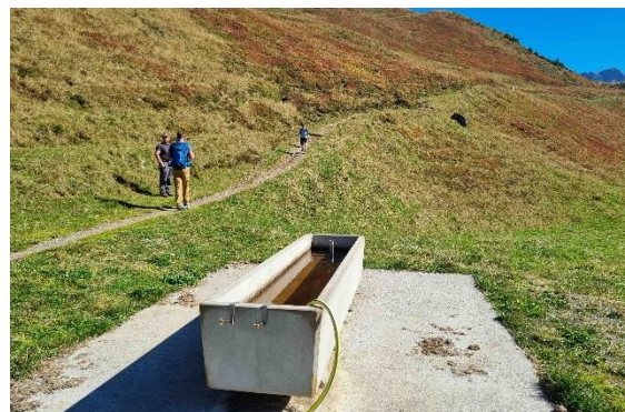
Abb. 47 Viehtränken mit umgebend befestigtem Platz.
