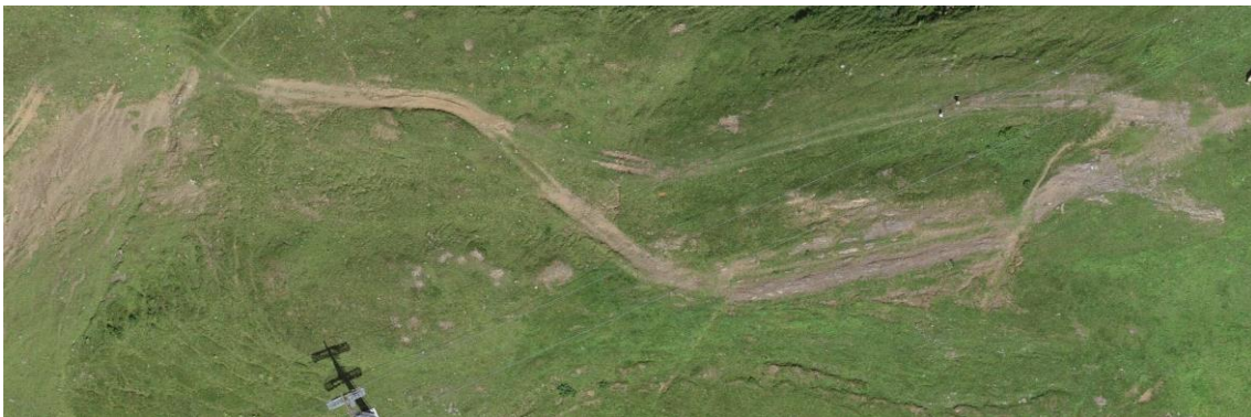
Abb. 71 Im Bodenschutzkonzept klären: Sanierung paralleler Fahrspuren auf mind. 300 m Länge mit «Substratverdichtung mittels 30 cm tiefem Einfräsen des Bindemittels Kalk»
