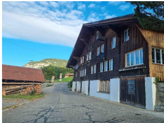
Abb. 50 Wohnhaus bei der Strasse Hohflueh-Käserstatt
