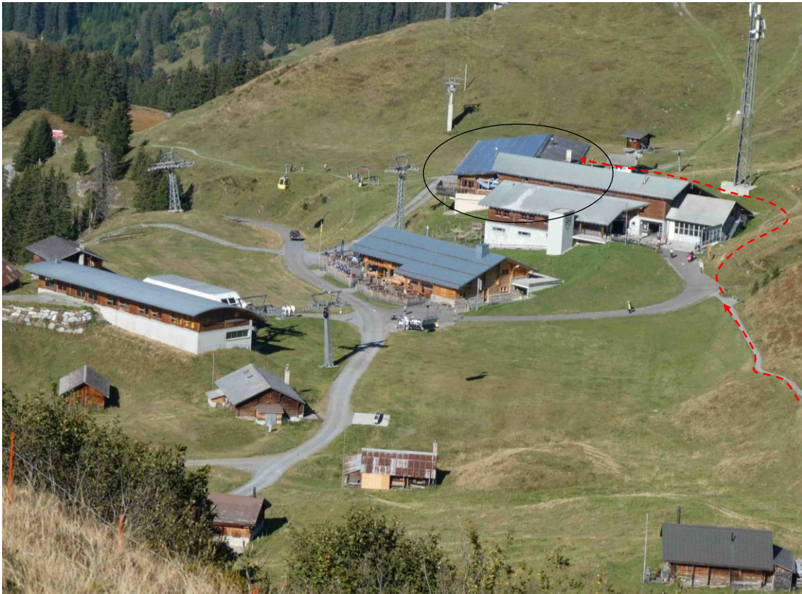
Abb. 32 V2: Leitungseinführung (rot gestrichelt) in die Zentrale im alten Bergrestaurant (schwarzer Kreis)
