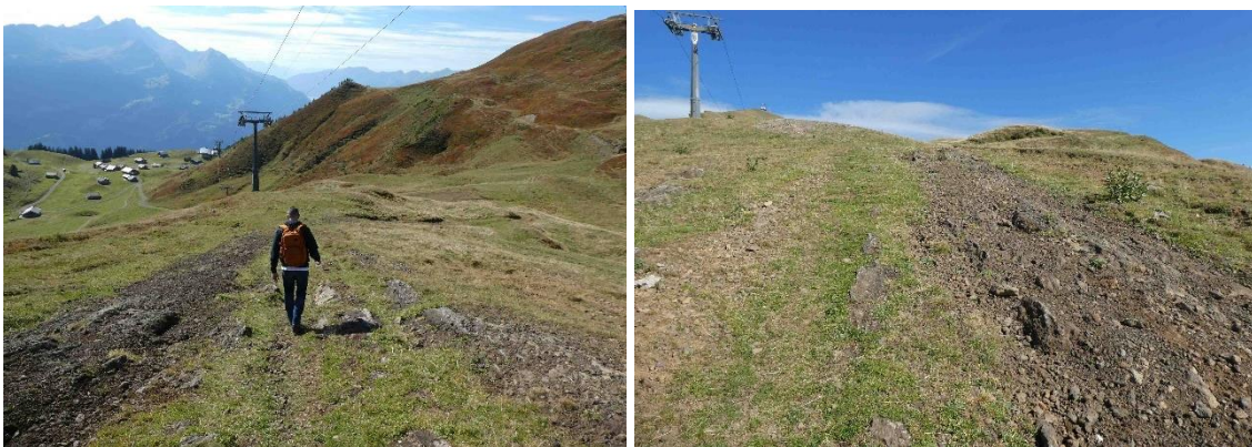
Abb. 69 Unbefestigter Fahrweg auf der Skipiste nordwestlich des PVA-Perimeters
