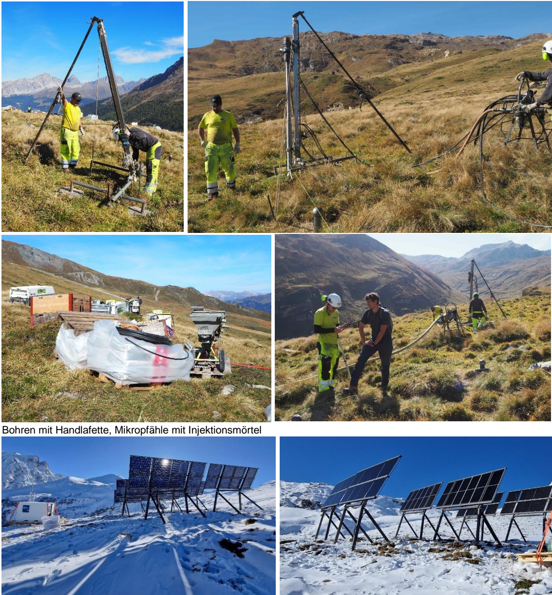
Abb. 27 Fotodokumentation Bauablauf Modultisch
