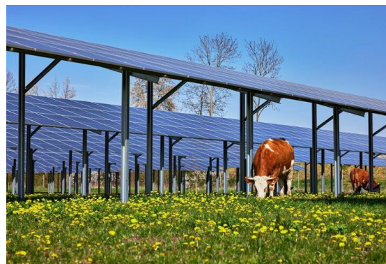
Abb. 53 Agri-Photovoltaikanlage im Landkreis Freising. (Bildquelle: OneSolar International GmbH, 2023)
