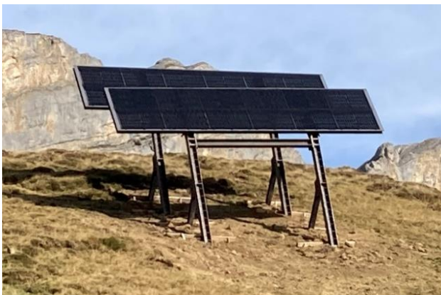
Abb. 25 Testanlage (I) und Optimierung des Materialbedarfs durch Konstruktion mit Abspannseilen
